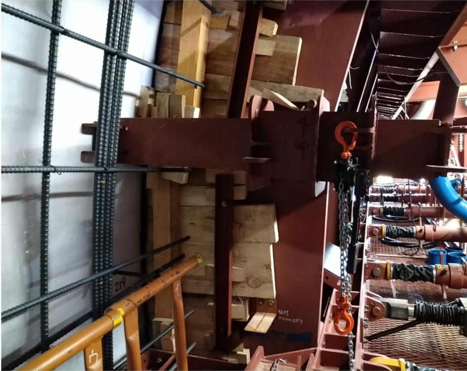
鉄筋区間でも取り扱い可能なスライド式バリ受けを採用することでバリ受け作業の時間短縮が望めます。
